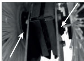
Рис. 4 Установка соединительных пластин крепления отвала
